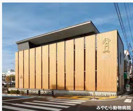
設計当時、大臣認定を取得するためにLVLの耐火実験が進められていて、このプロジェクトは採用第一号として最適な規模と条件で、LVL木層ウォールと在来軸組構法を併用して実現しました。LVL木層ウォールの施工時における苦労は主に3つありました。1つ目は建て方時の精度、基礎との取合いは1mm精度を要求され、LVLパネルを基礎へ取付ける際のアンカーボルトはコンクリートに予め打込まず、ケミカルアンカーを後打ちすることになりました。2つ目は設備配置、構造用LVLに孔をあけて通すといったことや設備を埋め込むことが困難であるため、配線スペースの天井を下げて確保したり、金属の配線ラックを別で取付けたりする等の対処を行いました。3つ目はLVLの塗装で、南面のLVL木層ウォールや仕上げ用LVL(キーラムインテリア)にはラミナの積層面が表面に見えるものを使用しましたが、塗装前の表面がささくれて手に刺さってしまう点に苦労しました。在来軸組部分の被覆については、耐火被覆は厚さ12.5mmの強化せっこうボードを使い、待合室に面する斜め壁ではそのせっこうボードの上に仕上げ用LVLを貼っています。
