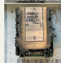
試験後の断面（耐火梁）
