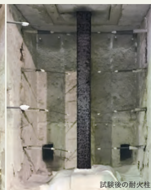
試験後の耐火柱
