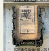
試験後の断面(耐火梁)
