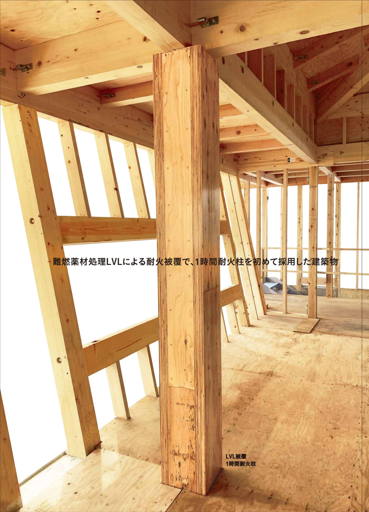
難燃薬材処理LVLによる耐火被覆で、1時間耐火柱を初めて採用した建築物
