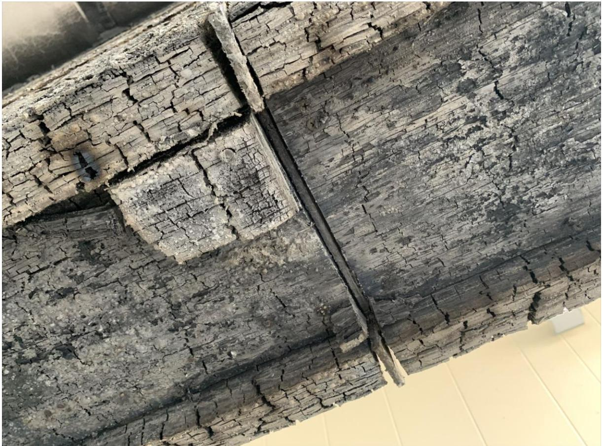
写真 4-14 被覆材下面脱落
